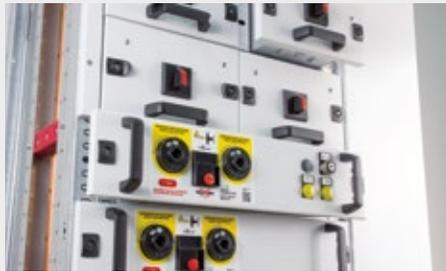
**Armadio misto:** armadio singolo o con vano cavi composto da cassette estraibili, cassette fissi, etc.
